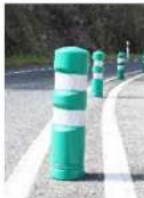
Baliza o captafaros horizontal retroreflectante
